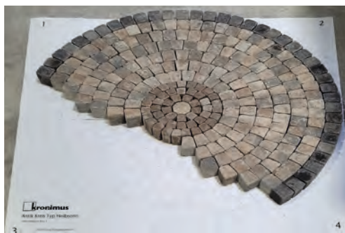
Verlegung mit Verlegesablonen
